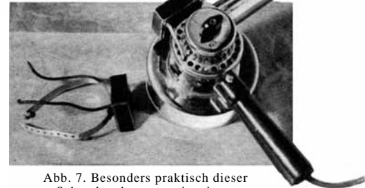
Abb. 7. Besonders praktisch dieser Schutzkondensator mit seinem Befestigungsband.
